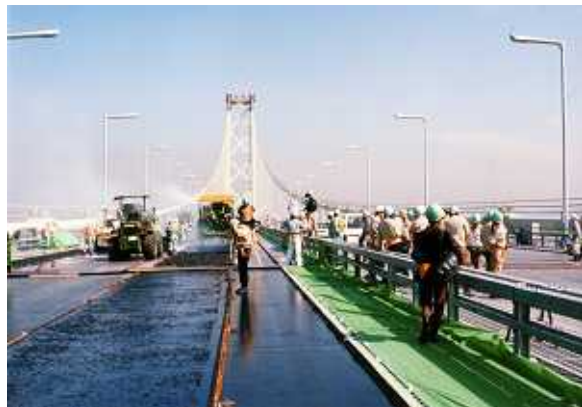
鋼床版グースアスファルト舗装の施工
