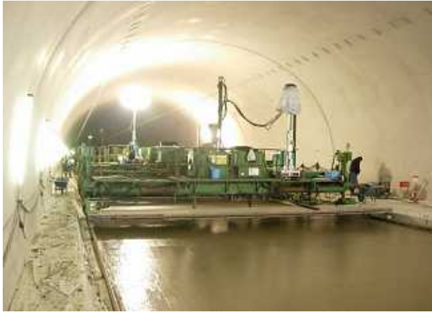
トンネル内コンクリート舗装の全幅施工（セットフォーム）
