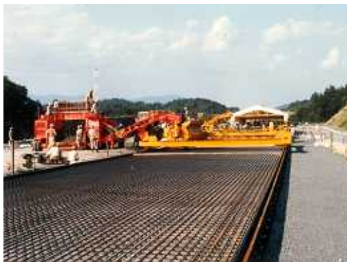
セットフォームによる連続鉄筋コンクリート舗装
